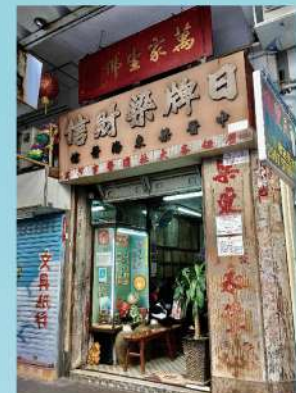
傳統跌打醫館（深水埗舊樓）
